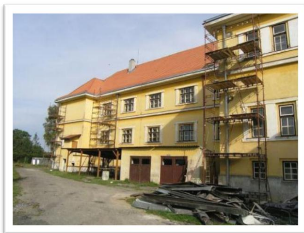
104. Škola během rekonstrukce střechy a okapů
