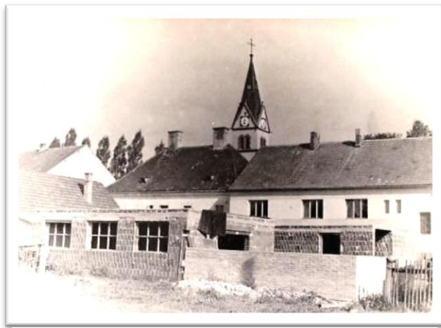
61. Výstavba kabin na hřišti
