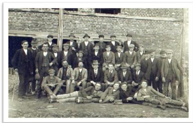
79. Dělníci, pracující na stavbě školy
